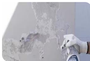
Aplicação em parede.
