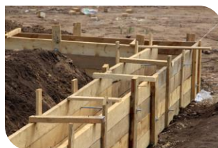
Aplicação em fôrma de madeira.
