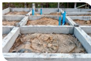
Aplicação em fundação.
