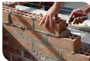
Aplicação em argamassa de assentamento.
