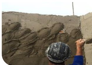
Aplicação em reboco.
