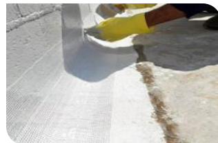
Aplicação como reforço de impermeabilização.
