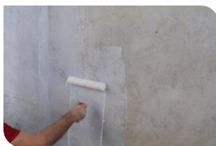
Aplicação em parede.
