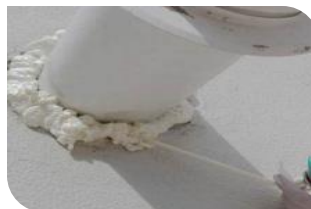
Fixação em dutos.
