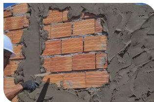
Aplicação em reboco.
