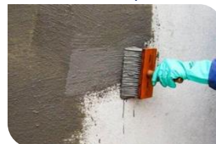
Aplicação em paredes externas (sem incidência solar).
