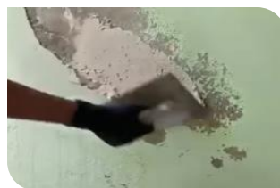
Aplicação em parede.
