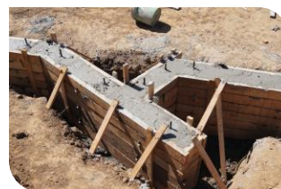
Aplicação em fôrma de madeira.
