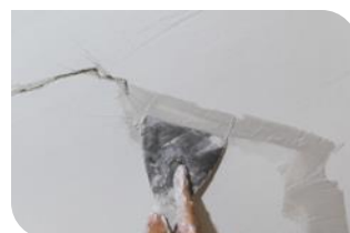
Aplicação em trincas.
