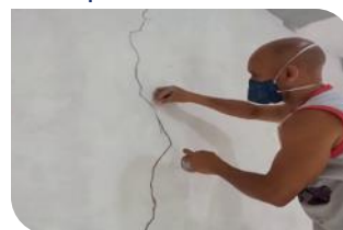
Aplicação em trincas
