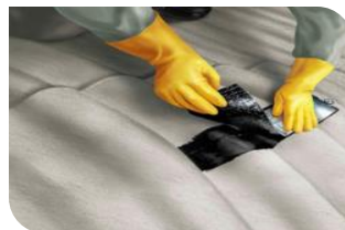
Aplicação em telhados.
