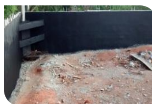
Aplicação em muro de arrimo.
