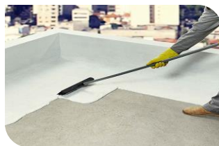
Aplicação em laje sem trânsito.
