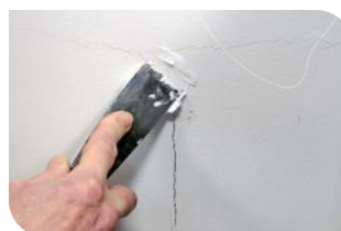
Aplicação em fissuras.
