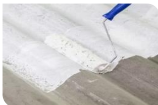
Aplicação em telhas de cimento.
