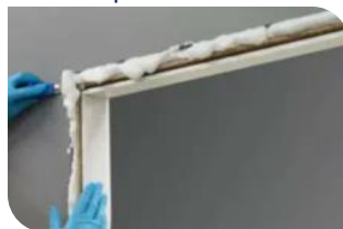
Preenchimento de batente de porta.
