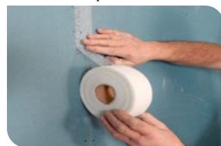
Aplicação em fissuras.
