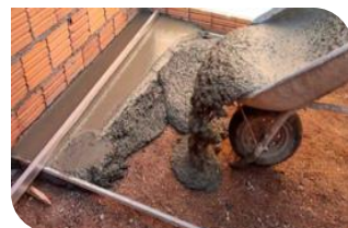
Aplicação em piso em contato com o solo.
