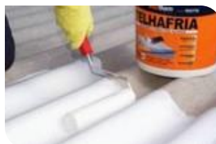
Aplicação em telhas de cimento.
