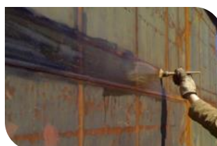
Aplicação em chapa metálica
