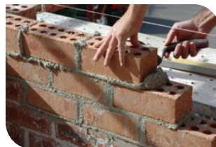
Aplicação em argamassa de assentamento.
