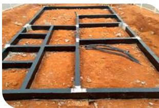
Aplicação em fundação/alicerce.
