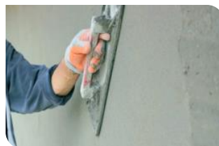
Aplicação em reboco.
