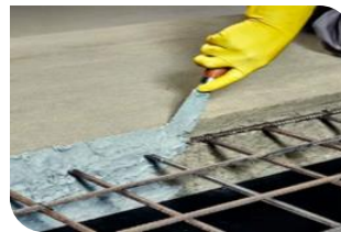
Aplicação como ponte de aderência entre concreto velho e novo.
