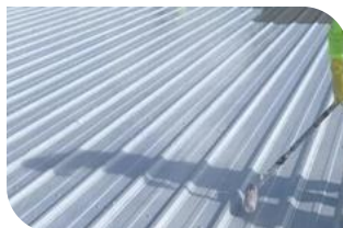
Aplicação em telhas galvanizadas.
