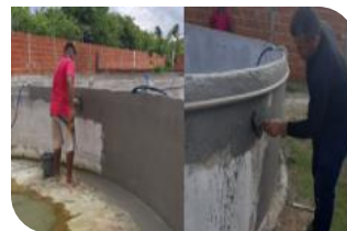
Impermeabilização de tanque de piscicultura.
