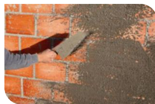
Aplicação em argamassa de chapisco.
