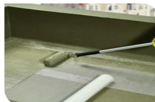
Aplicação como reforço de impermeabilização.
